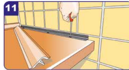
11 Für die Abschlussleisten ist es sinnvoll, Stecksysteme, bei denen der Träger auf der Platte befestigt wird, zu verwenden. Ist dies geschehen, wird das Leistenprofil von oben aufgedrückt. Für die Enden und Ecken gibt es extra Abschlusskappen.
